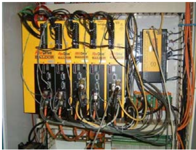
Arriba : Una conexión tradicional de un sistema de 5 ejes. Abajo : Una conexión con Ethernet PowerLink de 16 ejes.
