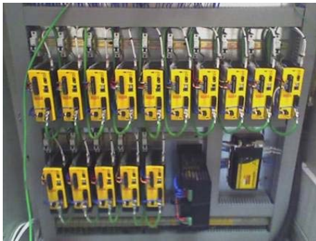
Arriba : Una conexión tradicional de un sistema de 5 ejes. Abajo : Una conexión con Ethernet PowerLink de 16 ejes.
